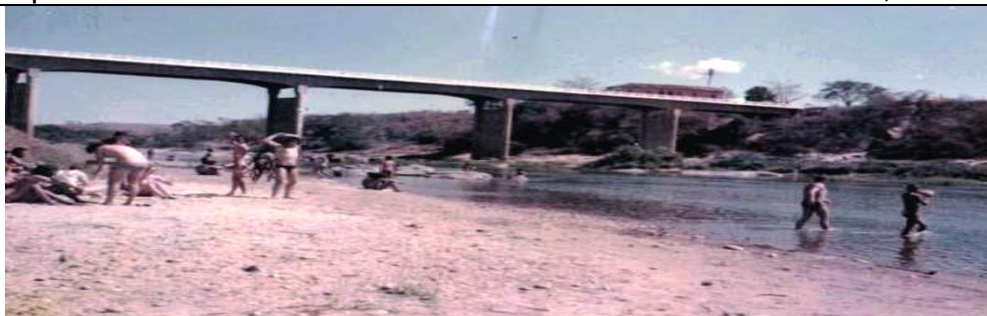
Figura 2 - Ponte sobre o rio Araçuaí.
